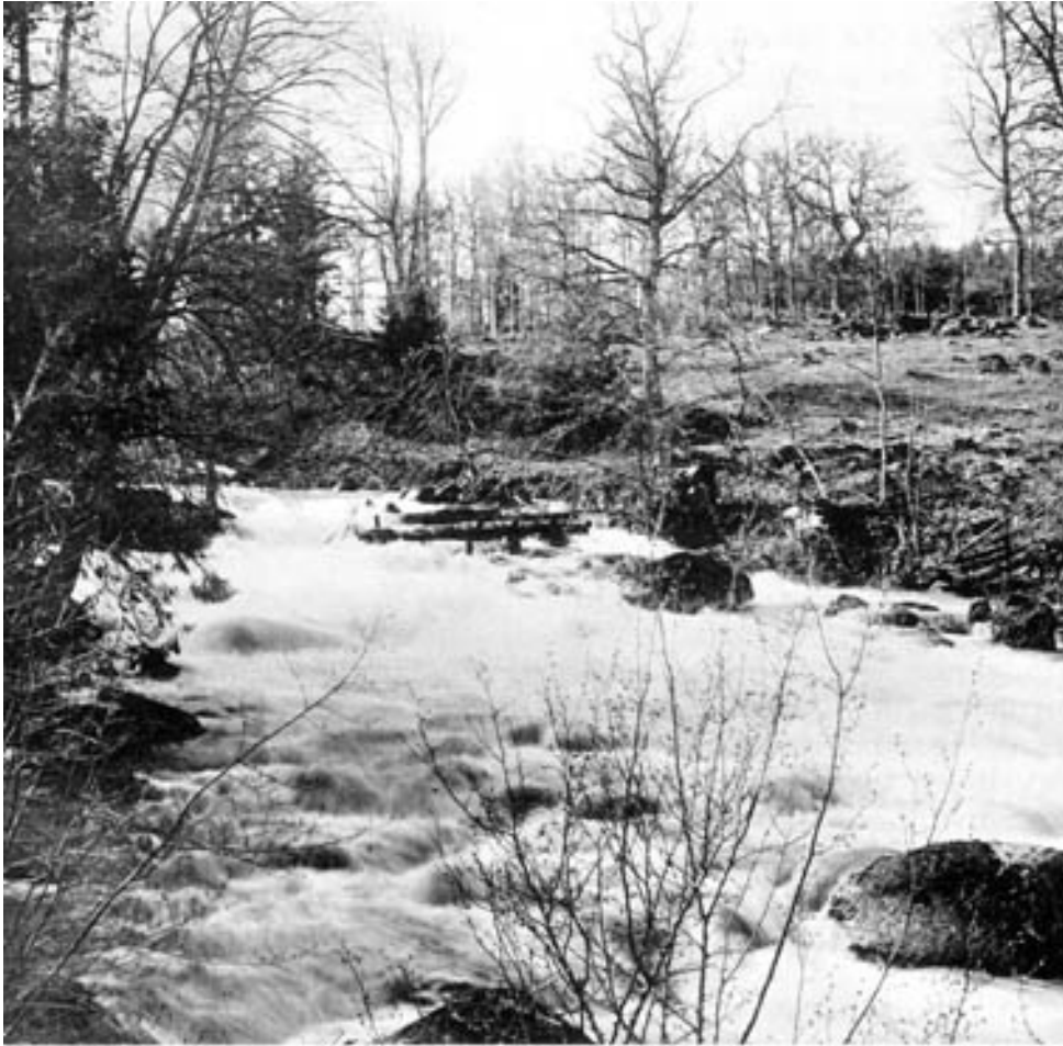
65. Skälstorpsfallet med byggnadsrester. Foto 1922.
